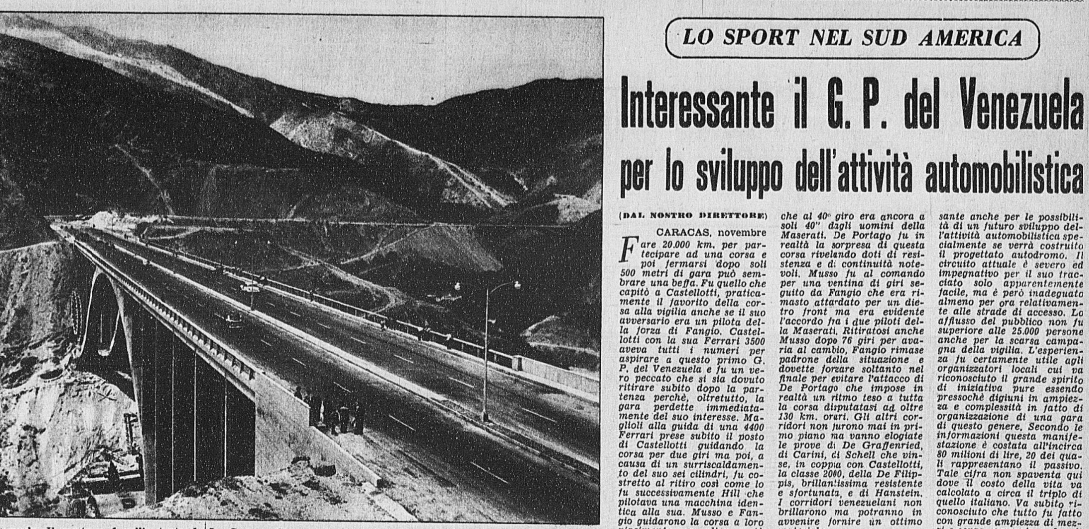
Venezuela. Il ponte n. 1 sull'autostrada La Guayra-Caracas, aperta al traffico due anni or sono. La sua costruzione richiese tre anni di lavoro e una spesa di 60 milioni di dollari. Con l'autostrada, lunga 10 miglia, sono state eliminate 329 curve e si è più che dimezzato il tempo occorrente per recarsi da Caracas a La Guayra.
